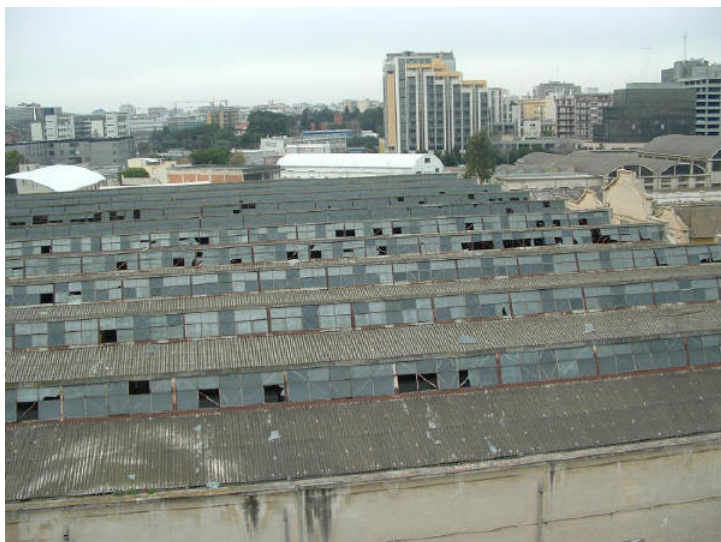
Figura 6 - La Fibronit di Bari prima degli interventi
